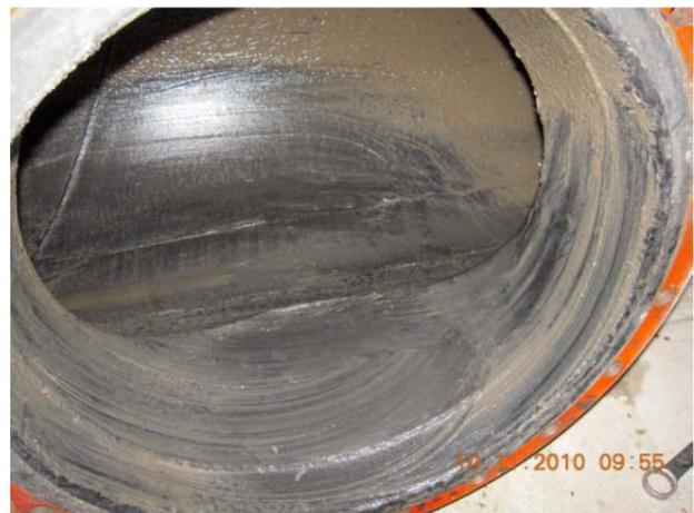
Un'ispezione puntuale delle stesse, a 10 anni dell'intervento, non ha evidenziato alcun deterioramento visibile di questo rivestimento interno ma nel frattempo si sono sempre più verificati dei distaccamenti puntuali ed irregolari dello strato di isolamento protettivo esterno lungo tutta la tratta *Lugano-Vedeggio*. In concomitanza di esse sono ben visibili le tracce di ossidazione-corrosione (ruggine) della superficie esterna delle tubazioni in acciaio.
