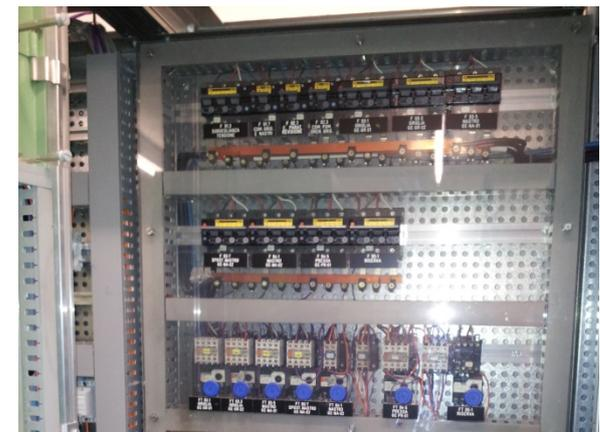
**Figura 23:** Componenti elettrici obsoleti nel quadro elettrico delle griglie
