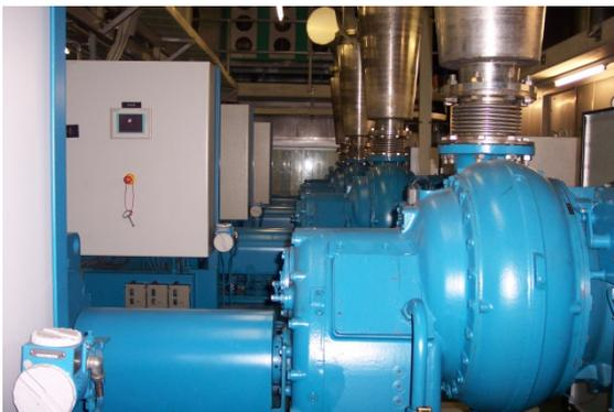
**Figura 27:** Stazione di insufflazione con quattro compressori e armadi elettrici
