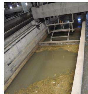
**Figura 12:** Griglia entrata, impianto di lavaggio sabbia e dissabbiatore
