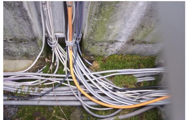
**Figura 34:** Nessuna separazione riconoscibile
