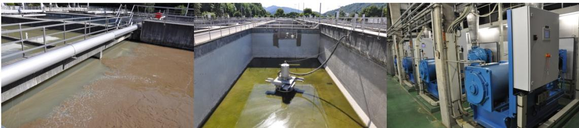
**Figura 14:** Transizione biologia bacini di decantazione primaria, aeratori OKI e turbocompressori
