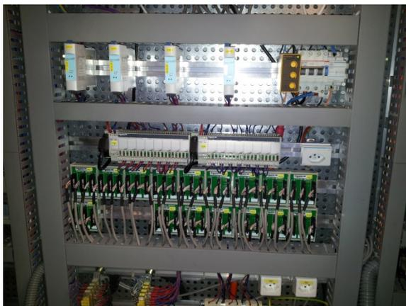
**Figura 22:** Nuovi componenti del controllore a logica programmabile nel quadro elettrico delle griglie
