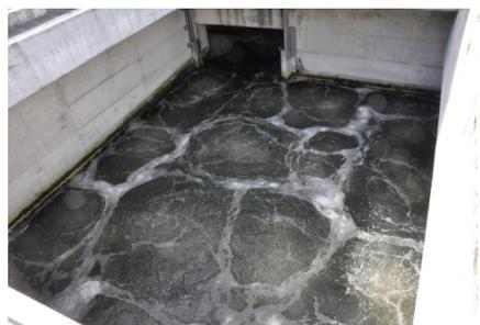
Figura 19: Impianto di sollevamento filtrazione e cella filtrante
