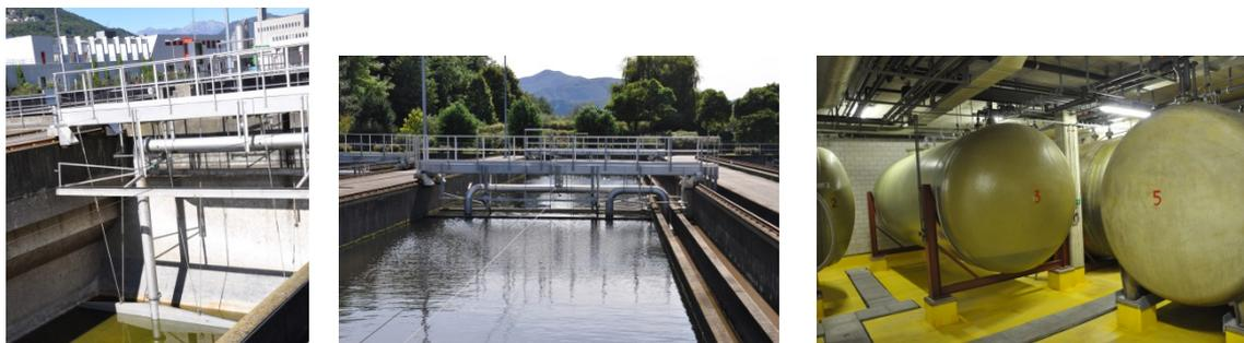
**Figura 15:** Carri ponte aspiranti dei bacini di decantazione finale e traslazione a cavo, serbatoi di precipitanti
