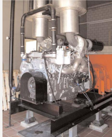
Per un fortuito concatenarsi di guasti quest'ultimo ha subito un surriscaldamento tale da creare un principio d'incendio e deteriorare gravemente cilindri e pistoni.
